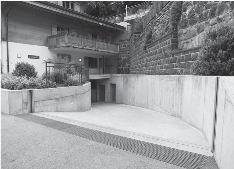
Zur Verhütung von Schäden müssen die Gebäudeeigentümerinnen und -eigentümer ihr Haus gegen Sturm, Hagel, Hochwasser und andere Naturgefahren ausreichend schützen: Links und rechts der Tiefgarageneinfahrt angebrachte Führungen für eine mobile Hochwassersperre.
