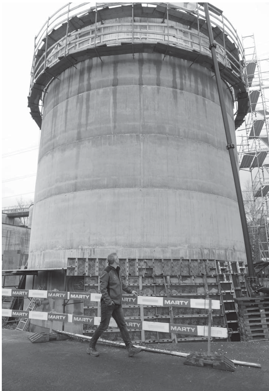
Der alte Turm der Biogas- und Faulanlage wird abgerissen, und zwei neue Türme sind im Aufbau.
