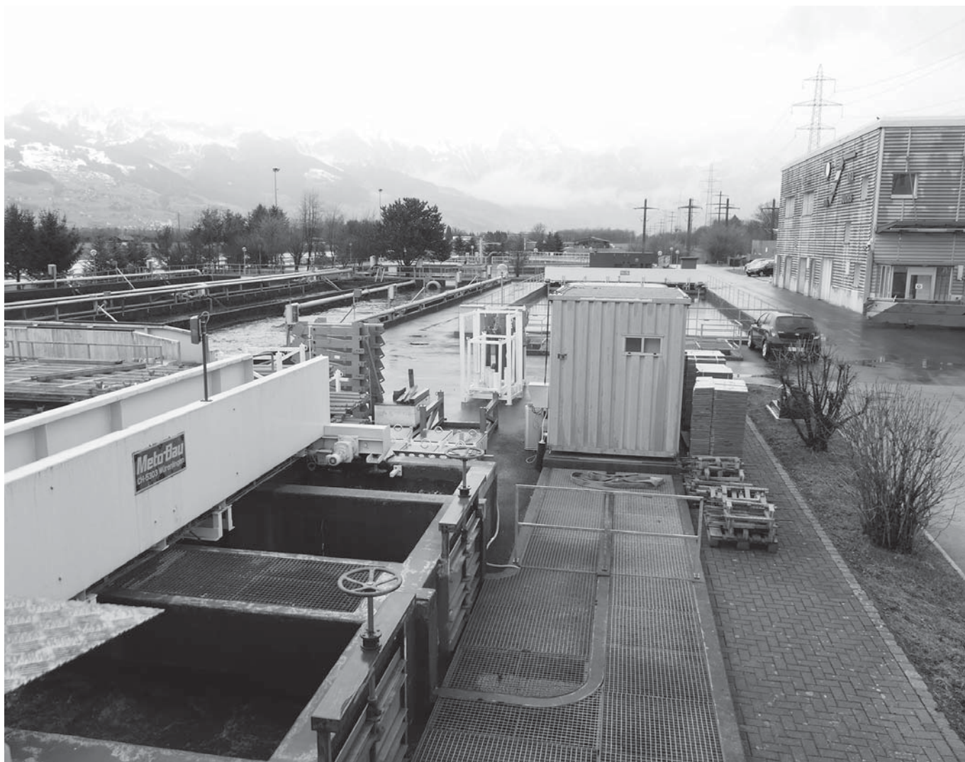
Vom Büro aus sieht man die Klärbecken.
