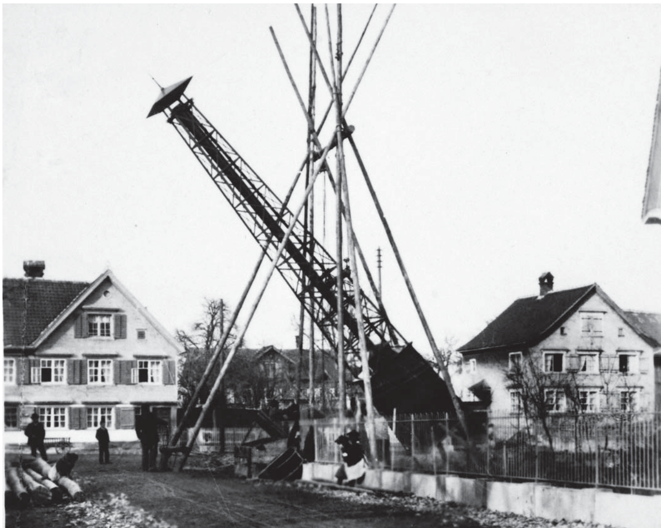
Montage der Mast-Transformatorstation 1903 an der Ecke Schulhausstrasse/St. Gallerstrasse
