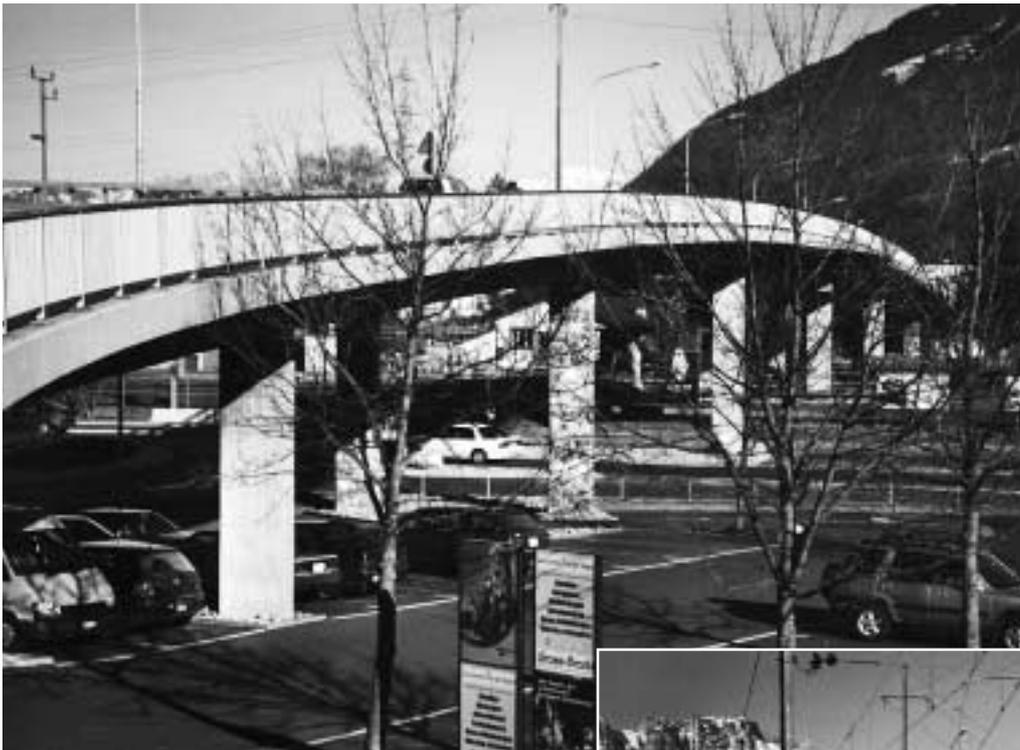
Vorgespannte Betonbrücke über Strassen und Gleise im Bahnhofsüdkopf. Das Bauwerk ruht auf 14 Pfeilern. Es ersetzt den mit Barrieren geschützten Niveauübergang Rheinstrasse.
