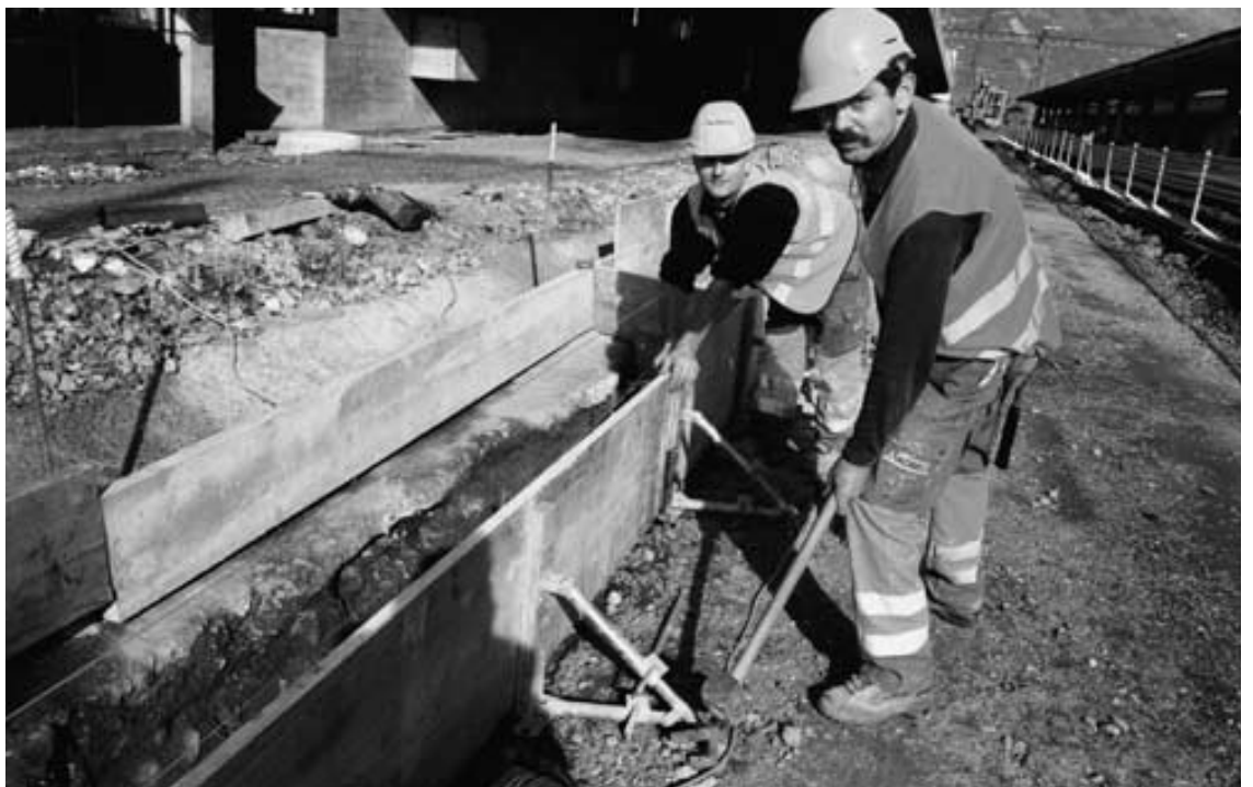
Zwei Bauarbeiter – sie verstehen ihr Handwerk und tragen dazu bei, dem Grenzbahnhof zu neuer Ausstrahlung zu verhelfen.
