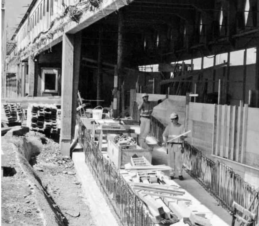
*Das Treppensteigen verschwindet. Rampe als neuer Zugang zu den Zügen auf dem Perron 3 im Bau (Aufnahme Mai).*
