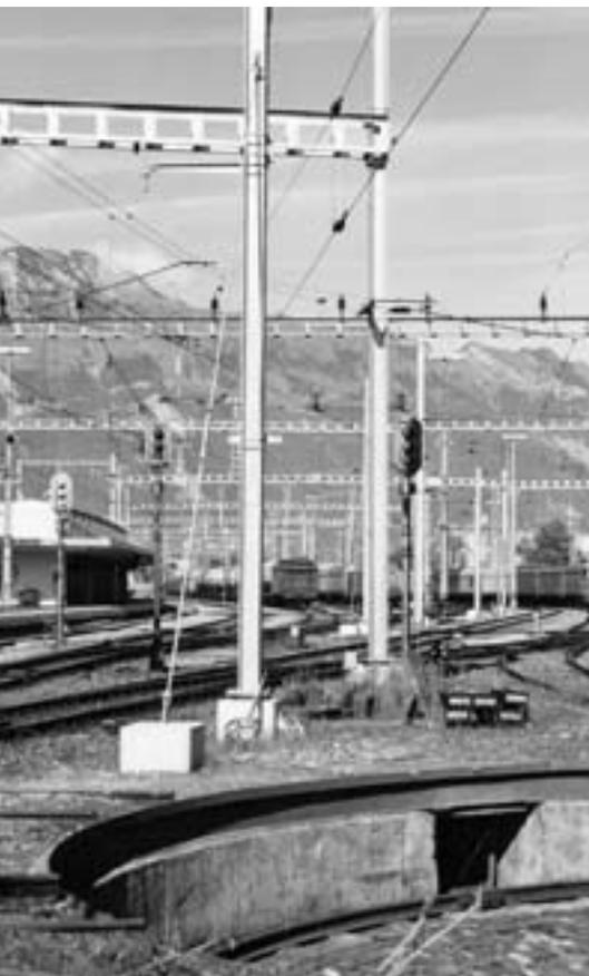
*Neue Fahrdrähtaufhängung, Stahlträger überziehen die Gleisfelder des Bahnhofs. Sie haben die alte Drahtjochanlage abgelöst.*
