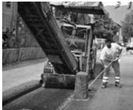
«La fresa»: Die Belagsfräse trägt den alten Deckbelag ab.
