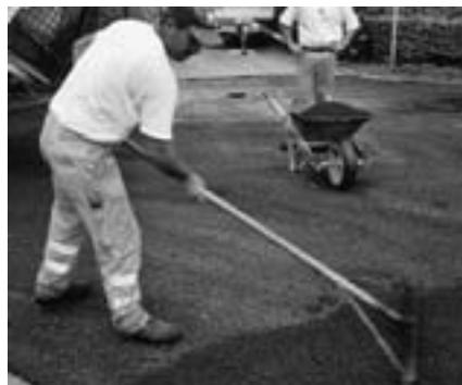
Zügig voran: Die Krucke ersetzt die Einbaumaschine.
