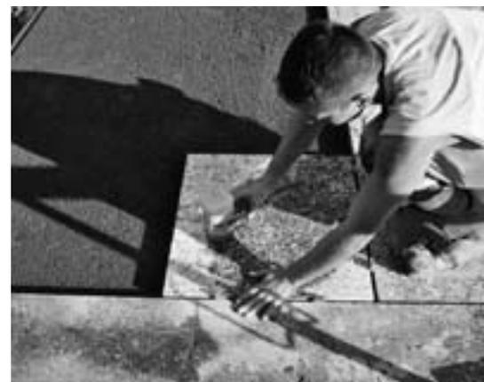
*Ein Bauarbeiter formt die Platten auf den Millimeter genau zu einem Ganzen.*
