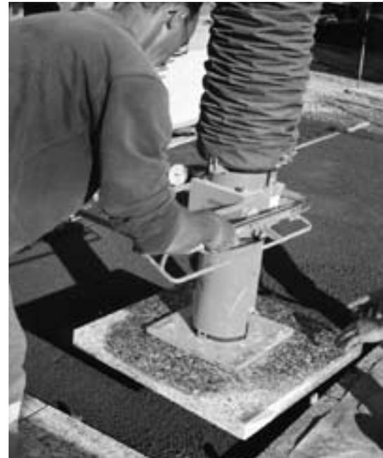
*Bau des Natursteinbelags der Fussgängerflächen entlang der Bahnhofstrasse. Ein Vakuum-Schlauchheber ersetzt die manuelle Arbeit. Ein Bauarbeiter steuert das Gerät und setzt die angesaugten fünf Zentimeter dicken und fünfzig Kilogramm schweren Gneis-Natursteinplatten an der gewünschten Stelle auf.*
