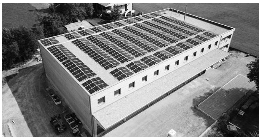
*Vorzeigeprojekt Rietli: Auf dem Dach produzieren 640 Quadratmeter Solarpanels Strom für rund 25 Haushalte.*
