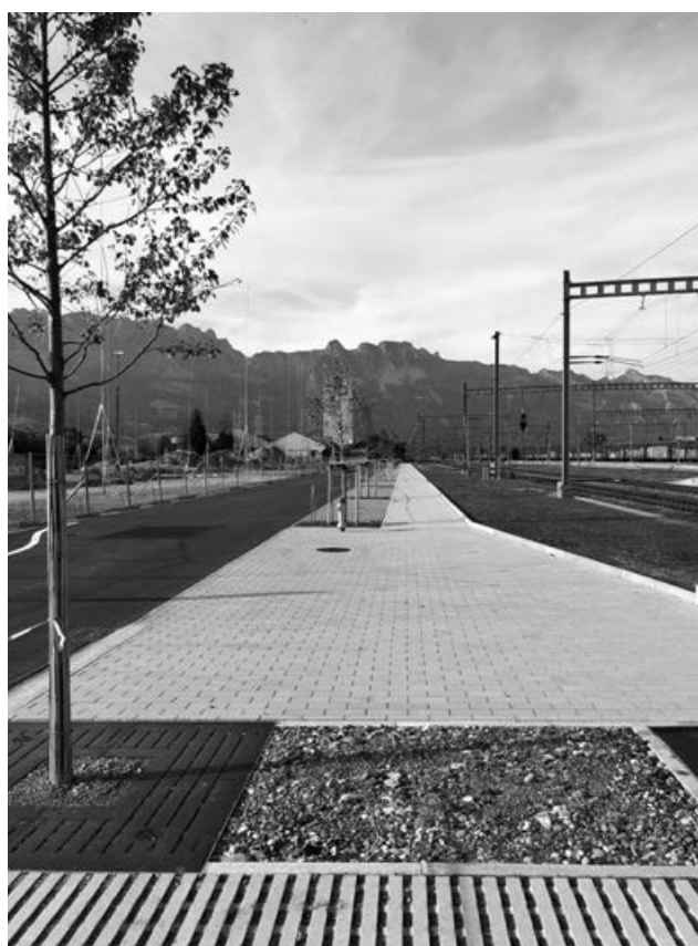
Blick nach Norden auf die neue Güterstrasse
