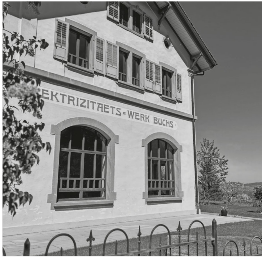
Wasserkraftwerk Tobelackerli des EWB am Fusse des Buchserbergs
