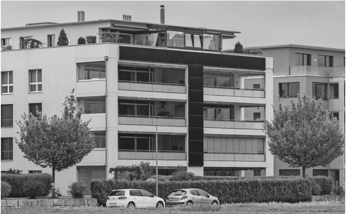
Dieses Wohnhaus in Buchs hat auf seiner nach Süden ausgerichteten Seite eine PV-Fassade (die dunklen Teile).
