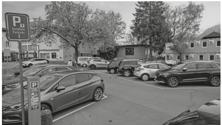
Das Areal «Chez Fritz» in Buchs wird in absehbarer Zeit zur Grossbaustelle.
