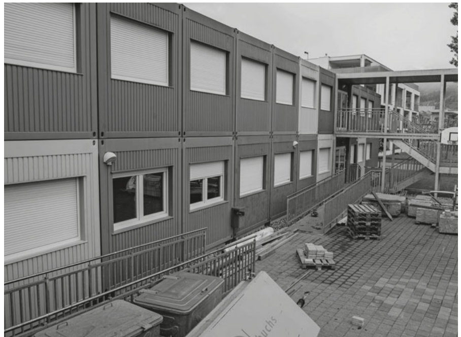
Am ehemaligen Standort der International School Rheintal wird im Sommer 2024 das Schulhaus Aeuli bezogen. Die Vorbereitungsarbeiten sind angelaufen.
