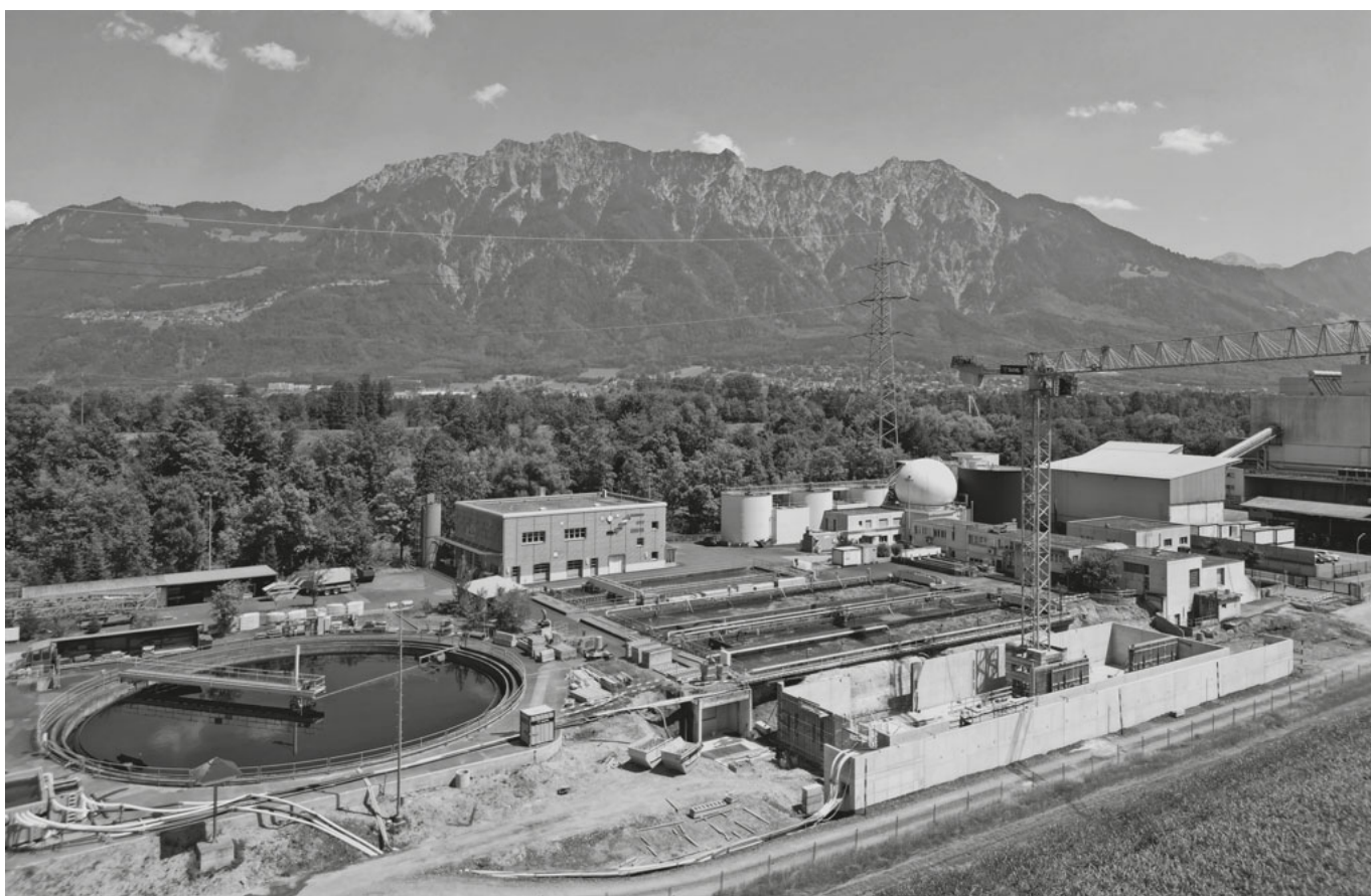
Drohnenaufnahme von der Grossbaustelle der ARA Buchs: Die Stimmbürgerinnen und Stimmbürger von Buchs, Sevelen und Grabs haben 2022 dem Ausbau zugestimmt.
