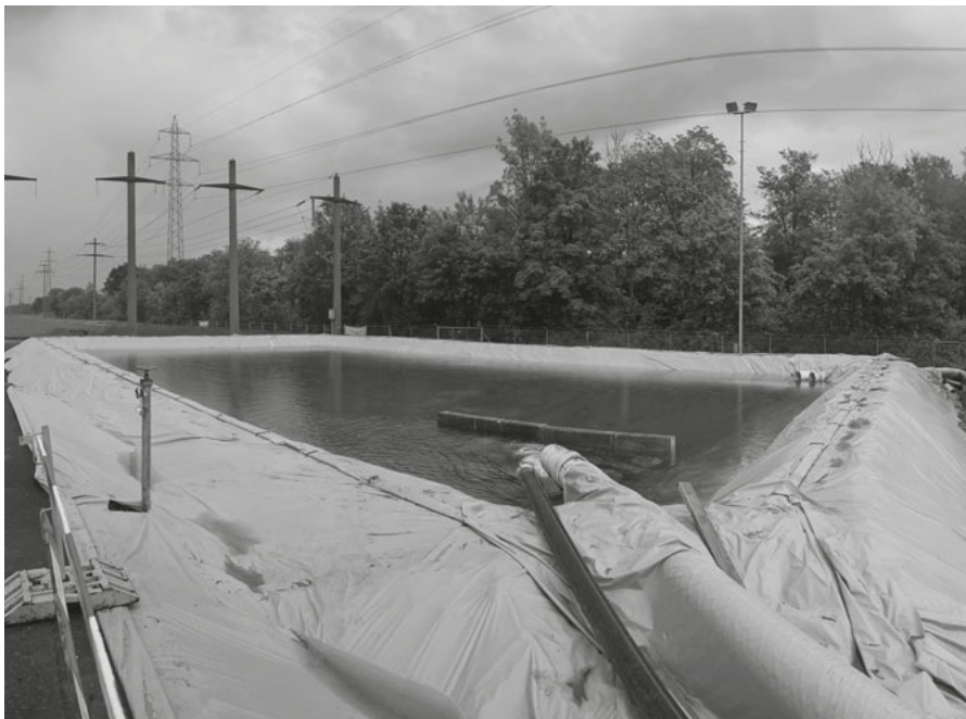
Für die Grundwasserhaltung braucht es ein Absetzbecken.
