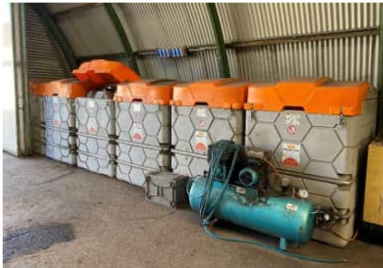
Abbildung 32: Tankanlage innerhalb der Maschinenhalle (6 doppelwandige Tanks; Hersteller: CUBE). 24.10.2022. Foto: KBA.
