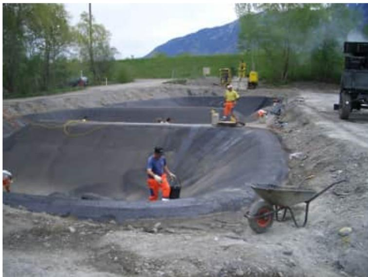
Abbildung 36: Bau und Abdichtung der Oxidationsteiche. 28.09.2005. Foto: VfA.
