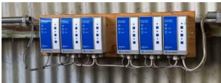
Abbildung 33: Überwachungssystem der Tankanlagen (optische Leckageanzeige). 24.10.2022. Foto: KBA.
