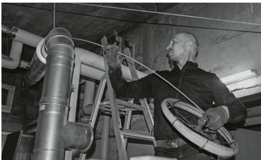
*Marco Knapp reinigt mit einem Besen das Abgasrohr einer Holzheizung.*
