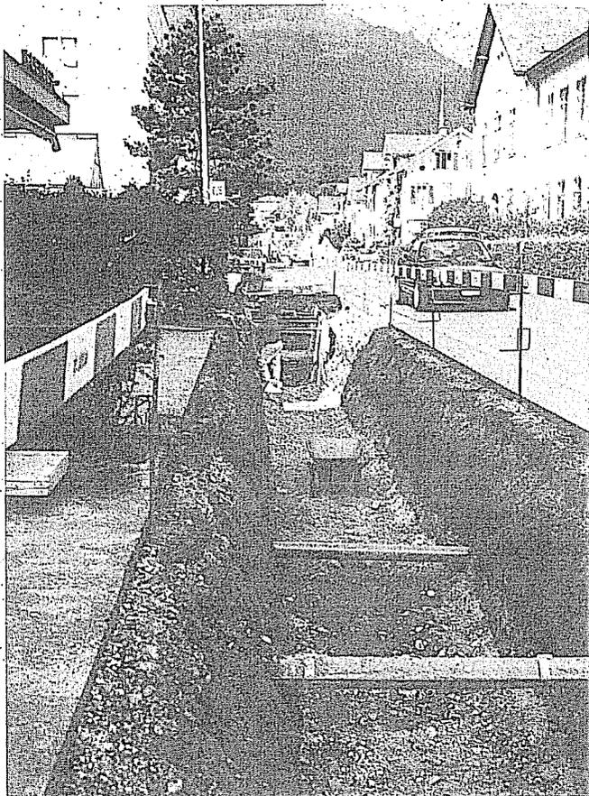
Im stark lehmhaltigen Boden halten die Gräben ohne Spriessung. Nach dem Aufschütten wird durch die Gemeinde das Trottoir saniert: eine Baustelle für zwei Vorhaben!
