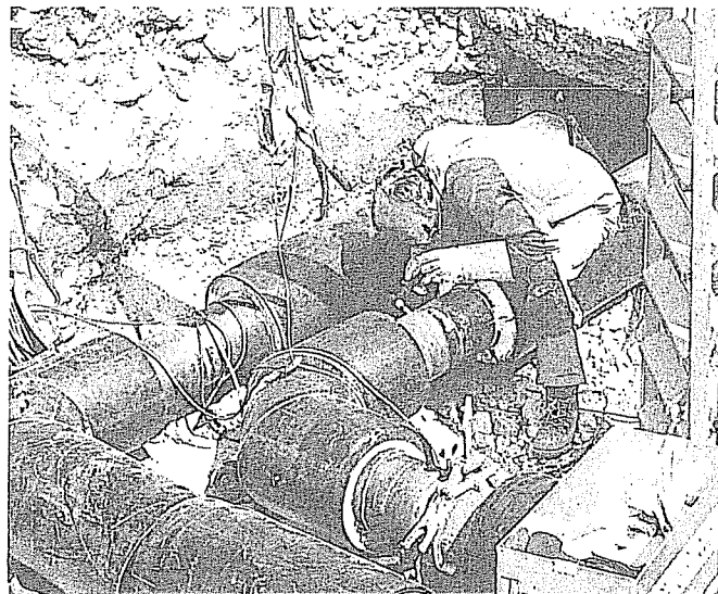
Oberstüdtlistrasse Schweissarbeiten am Fernwärmestrang
