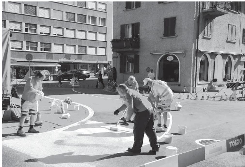
*An den Kreuzungen wird der Deckbelag hell eingefärbt, damit diese besser wahrgenommen werden.*
