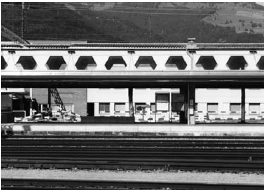
*Gedeckter Perron 3, Oberlicht-Dachkonstruktion mit sechseckigen seitlichen Öffnungen.*
