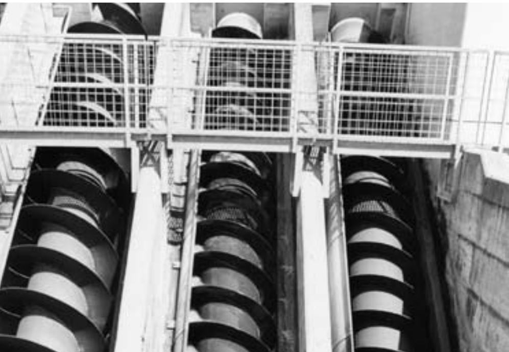
*Das Zulaufhebewerk der ARA: Es hebt das ankommende Abwasser zur Klärung um 6,90 Meter in die Höhe.*
