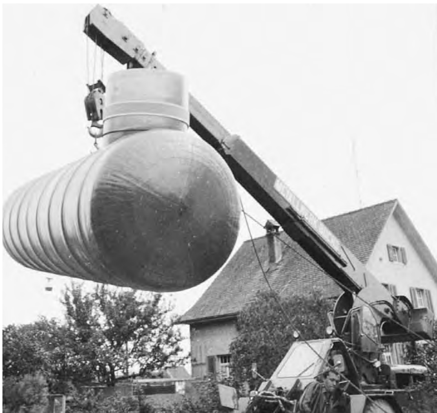
Versetzen des ersten MWB-Heizöltanks aus Kunststoff in Buchs in den 1970er-Jahren.
