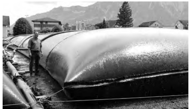
Die Geotube-Säcke füllten sich mit Schlamm.
