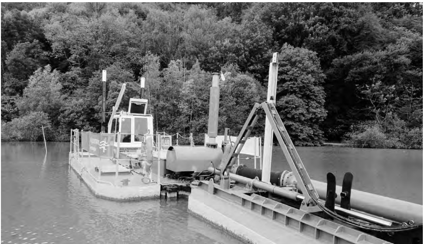
Der 23 Tonnen schwere Schwimmbagger entnahm die Sedimente umweltschonend.
