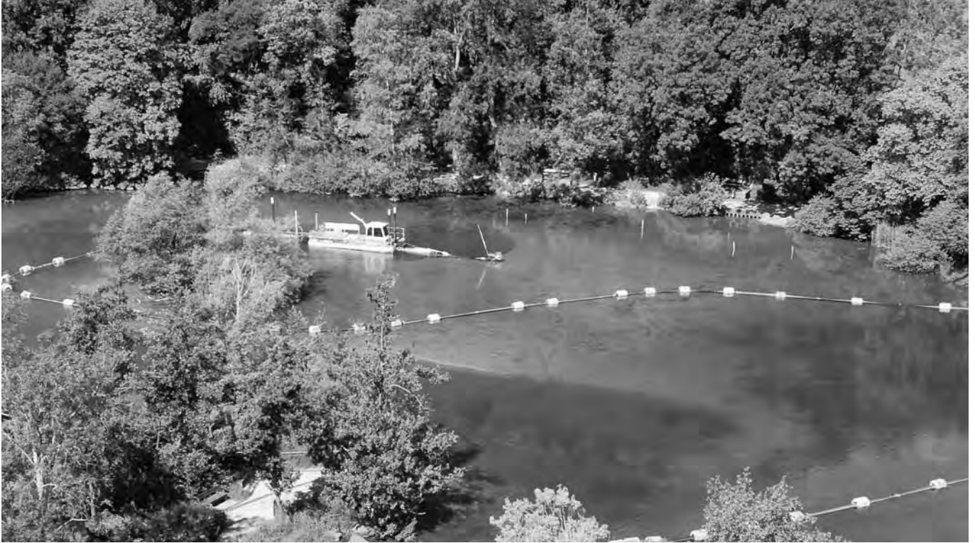
Gegen die drohende Verlandung: Pumpleitung und Schwimmbagger auf dem Werdenbergersee.
